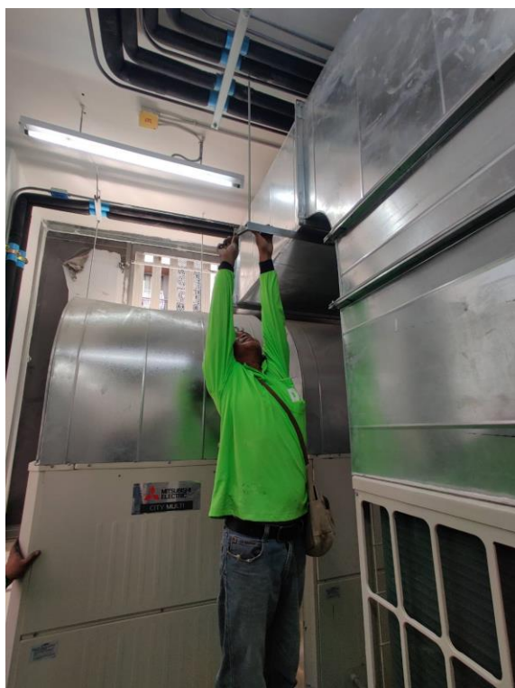
ภาพถ่ายการดำเนินการตรวจสอบการติดตั้ง/ยึดติดอุปกรณ์/ปรับหน้าการการระบาย/ตั้งค่าอุปกรณ์ CDU
