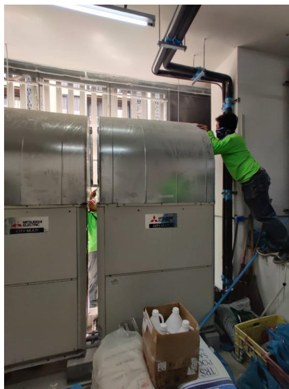
ภาพถ่ายการดำเนินการตรวจสอบการติดตั้ง/ยึดติดอุปกรณ์/ปรับหน้าการการระบาย/ตั้งค่าอุปกรณ์ CDU
